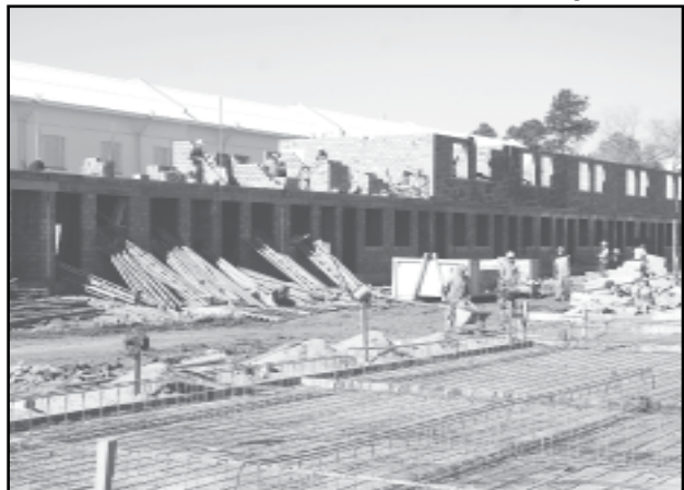
Mais 104 novas casas em construção na Vila DabDab
