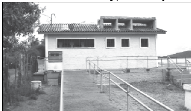
Sanitários do Lami receberam rampa de acesso para cadeirantes
