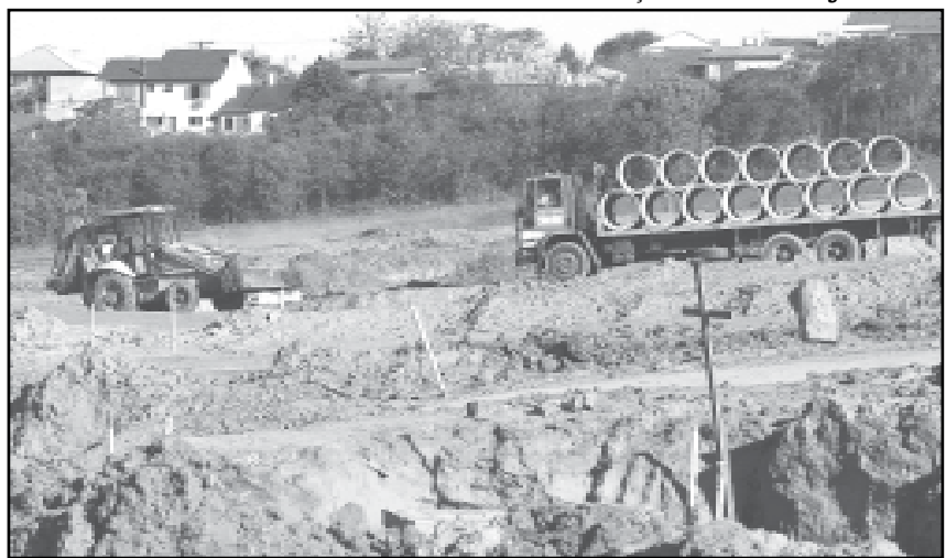
Quase metade das obras de infra-estrutura já foi concluída na área
