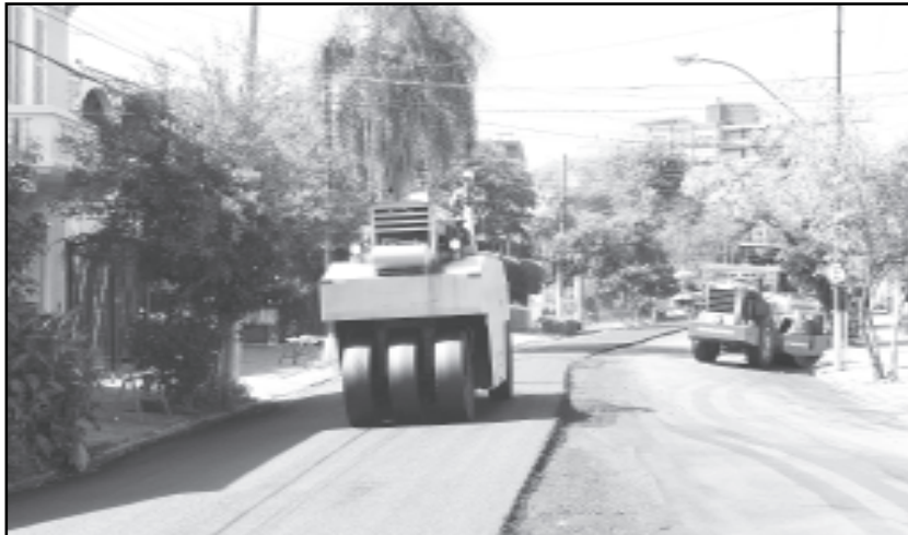
Segunda etapa da revitalização prevê obras em vias de grande circulação
