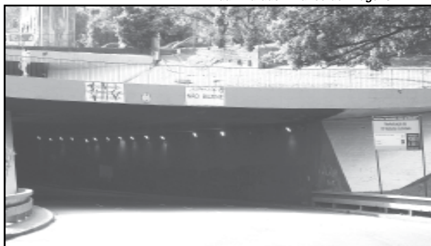
Revitalização tem 40% das obras concluídas
