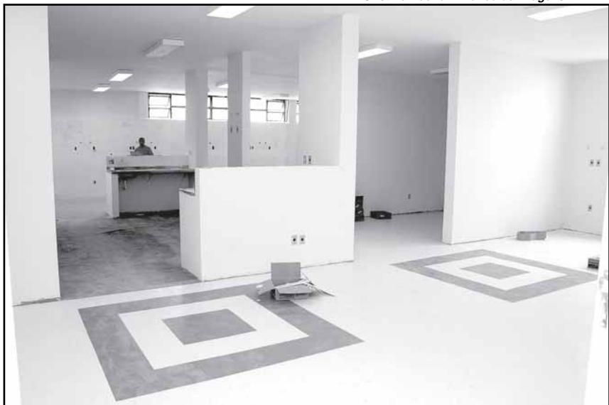
Obras foram concluídas em abril
