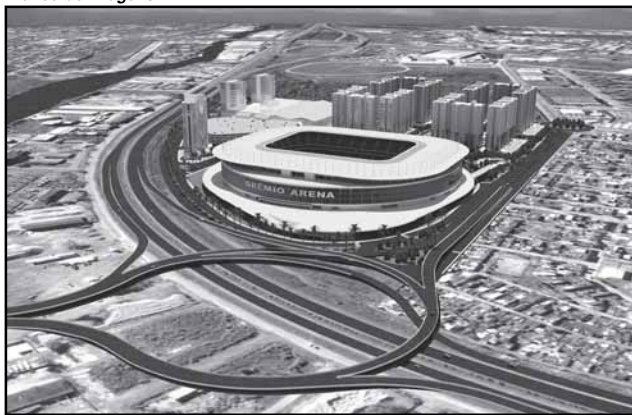
Arena do Grêmio terá 190 mil metros quadrados de área construída
