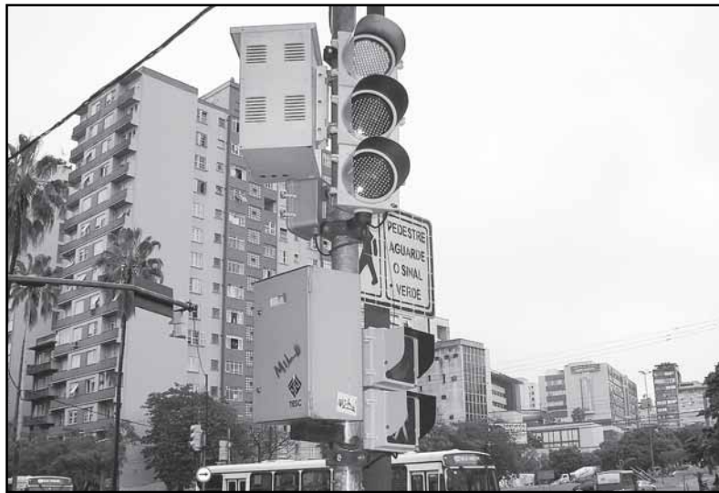
Semáforo com no break em teste na Paulo Gama com Osvaldo Aranha
