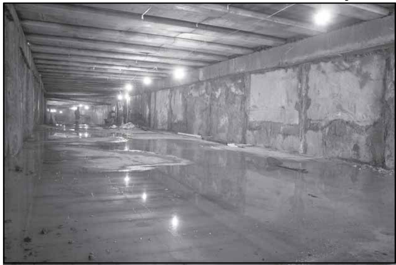
Galerias chegam a ter 7,5 metros de largura
