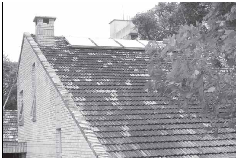
Dez painéis de energia solar aquecerão 600 litros de água
