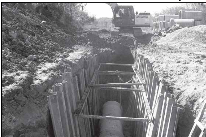
Até o final do mês de maio, foram assentados 2,6 km de tubulações
