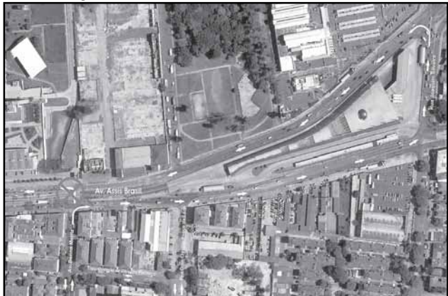
Uma das medidas para garantir fluidez foi o desvio na avenida
