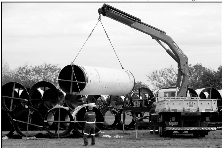
Outros 2,5 mil metros de tubos estão previstos para chegar em julho
