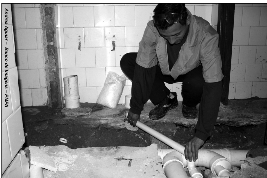
Entre os serviços previstos está o reparo de vazamentos hidráulicos
