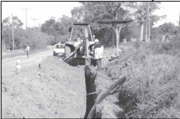
Obras de urbanização e saneamento (foto) estão em andamento na região
