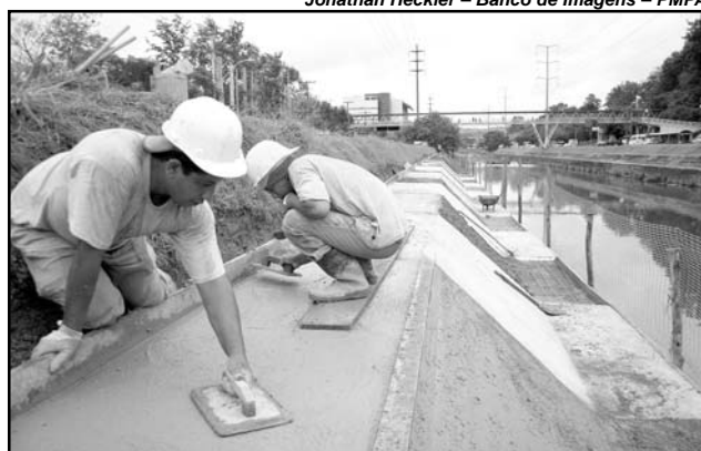
O Arroio Dilúvio já está com quatro quilômetros de taludes concretados
