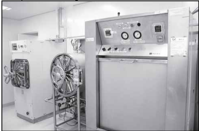
Foram investidos R$ 203 mil na reforma da área, que tem cerca de 200 metros quadrados
