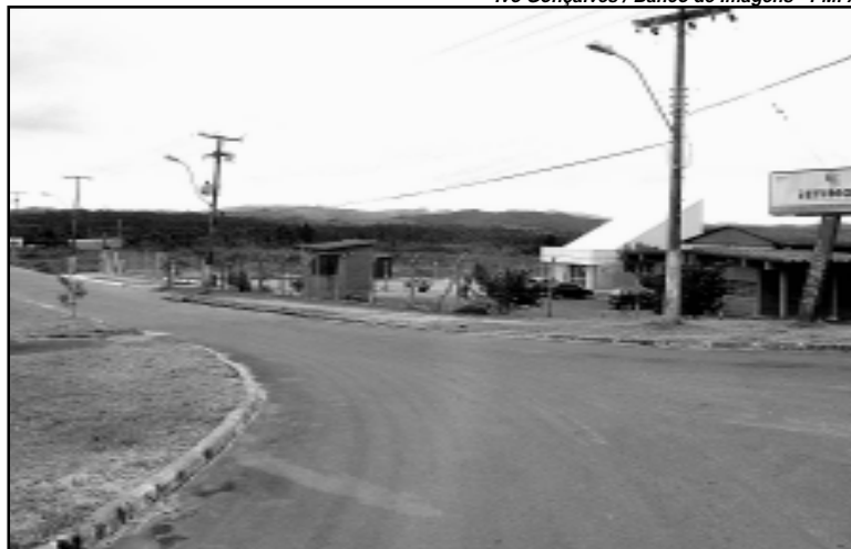
Local possui infra-estrutura básica
