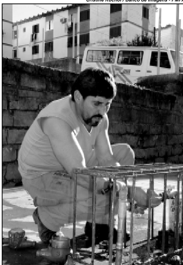
Serão realizados consertos de vazamento, substituição de hidrômetros e registros
