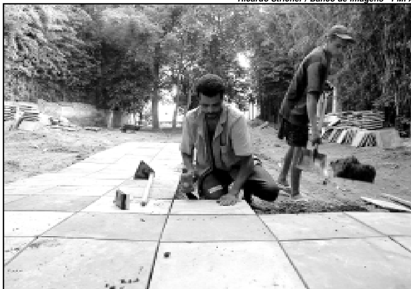
Obras começaram em março
