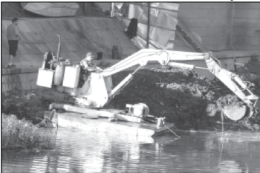
Já foram retiradas mais de 70 mil toneladas de material do leito do Dilúvio
