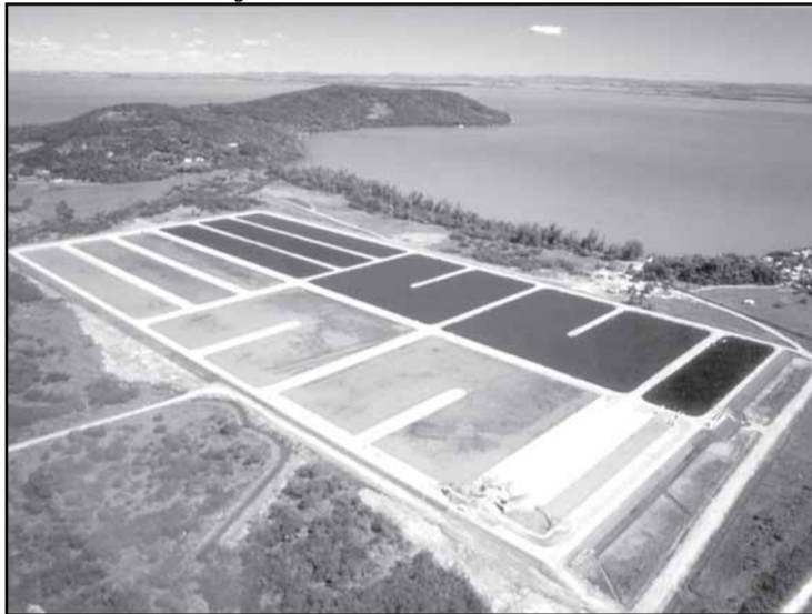
O tratamento completo do esgoto será realizado na moderna estação do bairro Serraria
