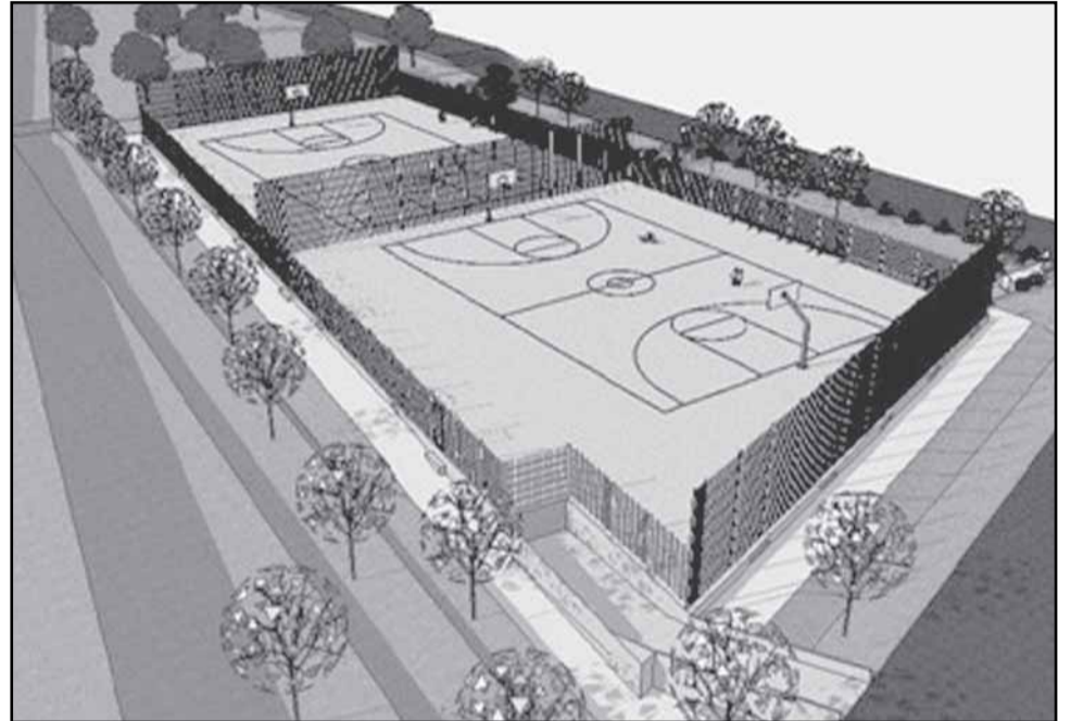
A bacia será em concreto armado e terá uma área para a prática de esportes na laje superior
