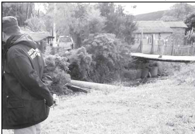
Defesa Civil, CAR Lomba do Pinheiro e representação do Orçamento Participativo realizam vistoria
