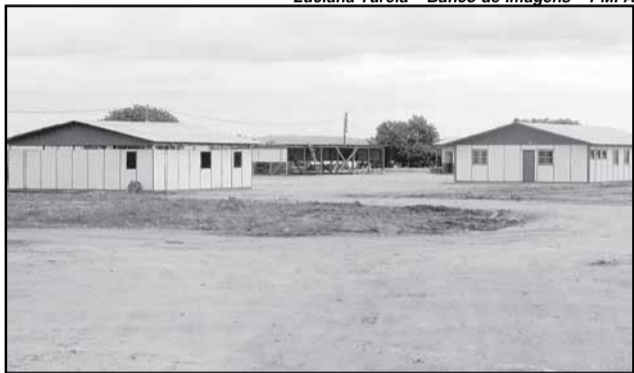
Canteiros de obras estão sendo montados na Zona Sul
