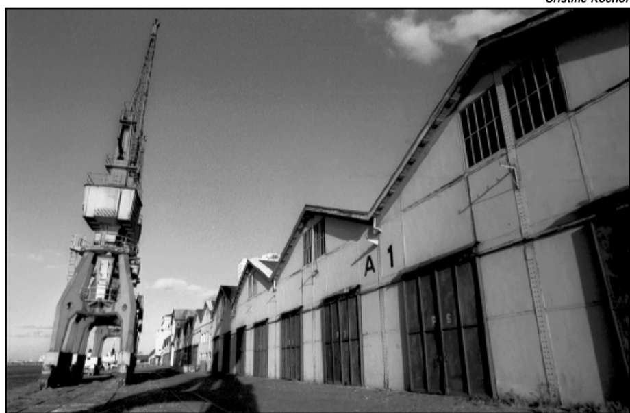
Armazéns: entre as Áreas de Interesse Cultural, está o cais do porto e a orla do Guaíba
