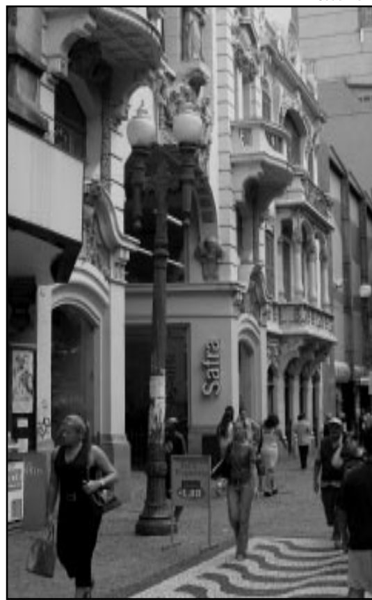
Reforma de prédios e espaços públicos revitalizam o Centro
