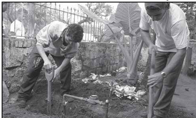
O Água Certa atende solicitações de serviços como instalação e troca de hidrômetros
