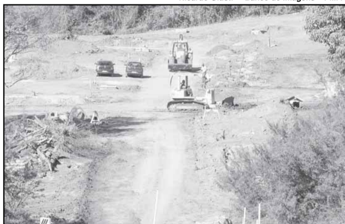
Novo terreno, com 33 hectares, já recebe obras de infraestrutura
