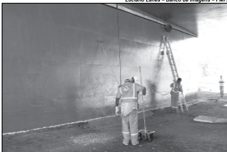
O trabalho integra o Projeto de Revitalização de 12 viadutos da cidade
