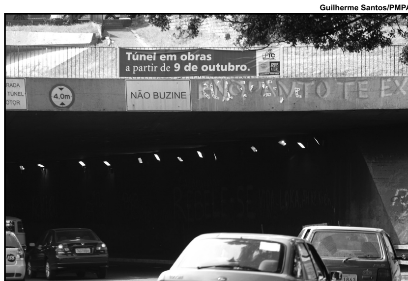
Faixa informando início das obras está na entrada do túnel
