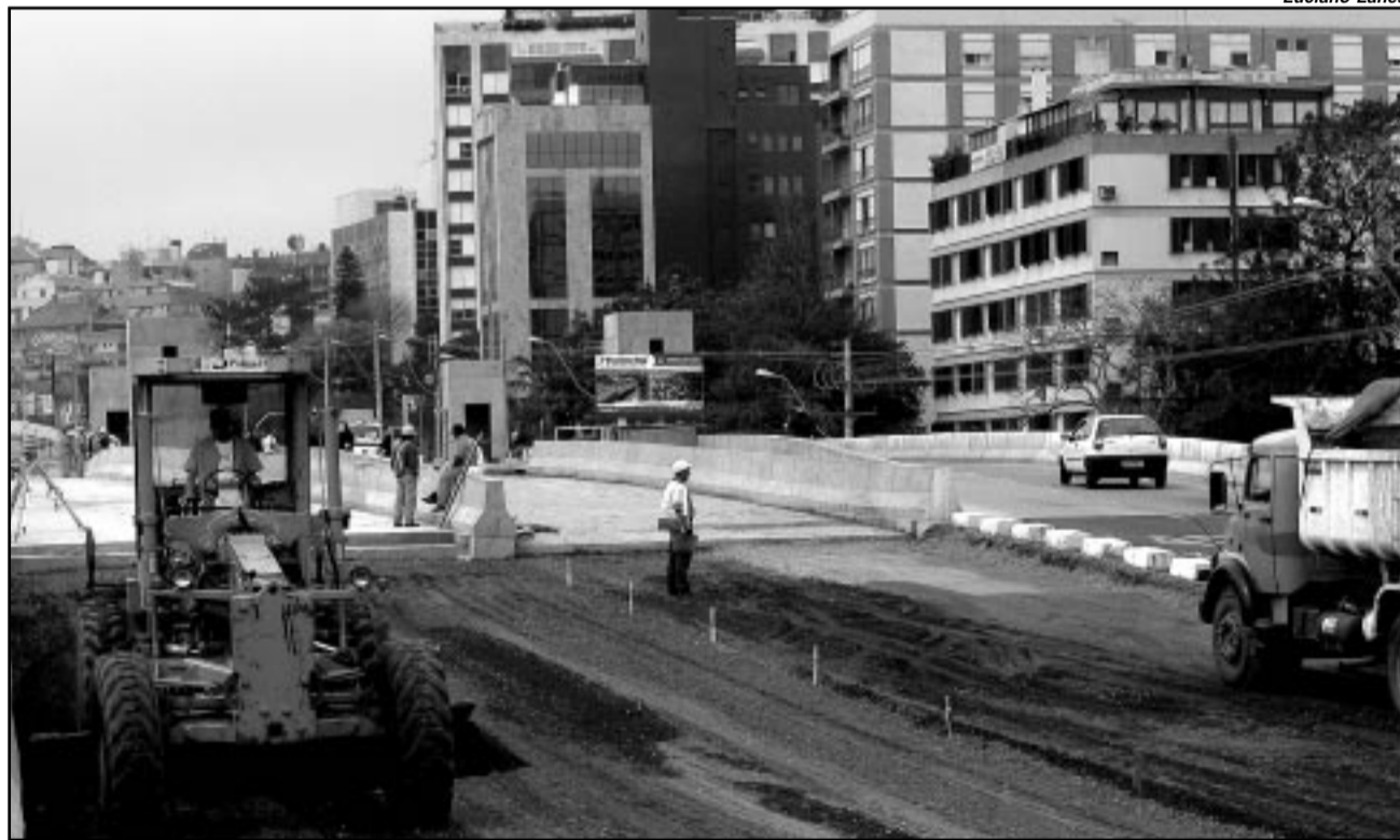
Em uma semana, já foram concretados 70 metros de pavimento
