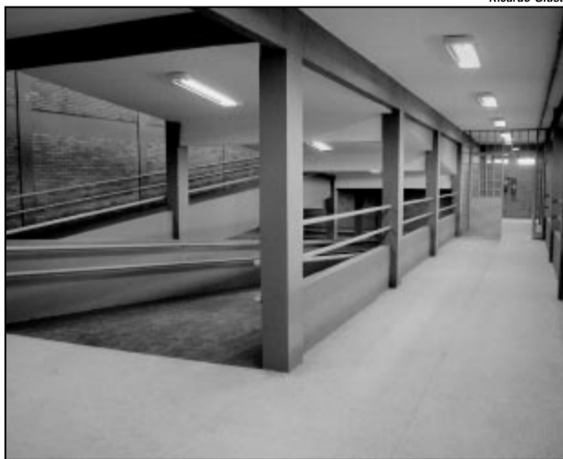
Rampas substituem escadas, permitindo a livre circulação dos alunos
