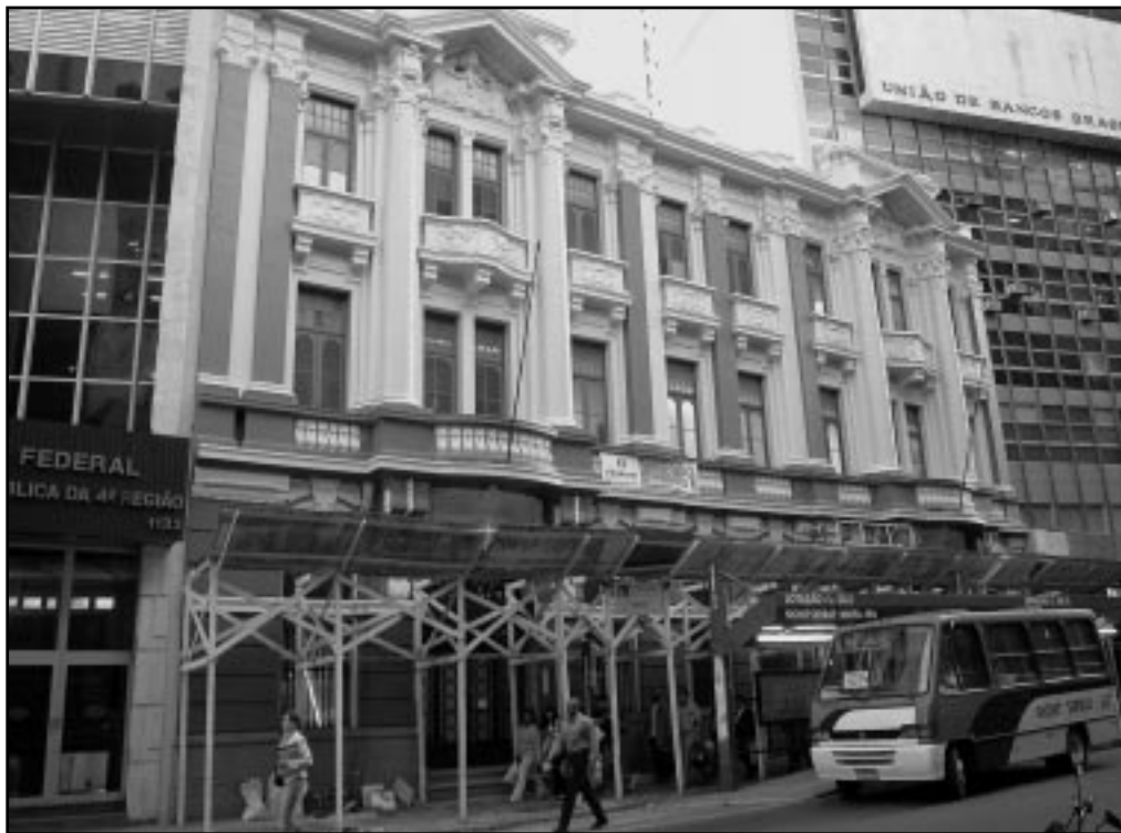
Prédio, que recebe acabamentos, proporcionará mais conforto ao usuário
