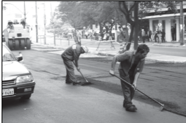
Das 37 vias, 24 já foram recuperadas, totalizando 790 metros de pista e 1,6 mil toneladas de asfalto
