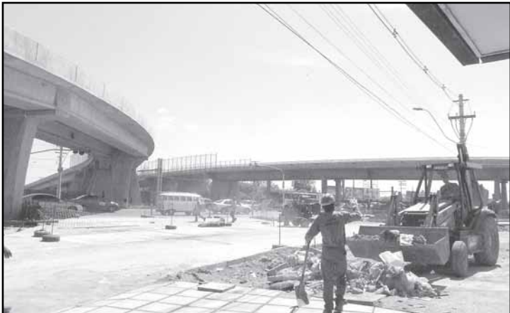
Entre as melhorias de infra-estrutura está o recém concluído viaduto Leonel Brizola, que facilita o acesso ao Bairro Humaitá
