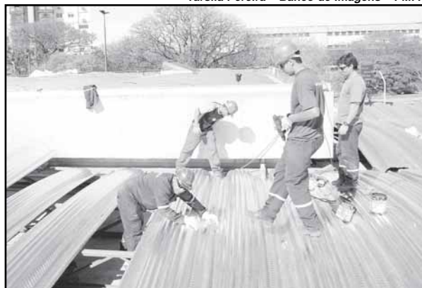
Telhado está sendo totalmente reestruturado
