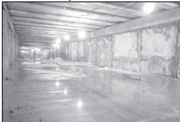
Conduto Alvaro Chaves-Goethe é exemplo dos investimentos do DEP
