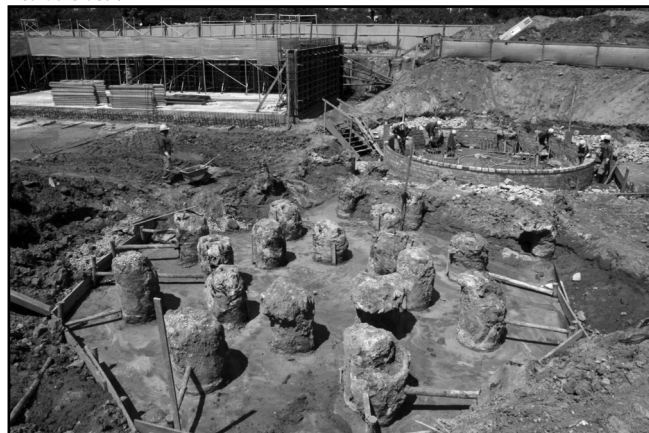
Executivo conferiu obras do Pisa em andamento no Cristal
