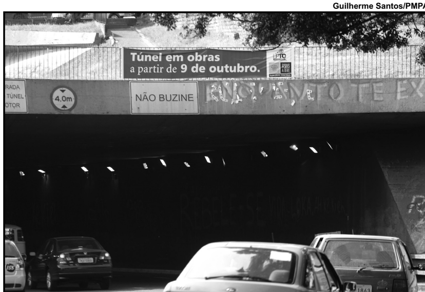
Faixa informando início das obras está na entrada do túnel
