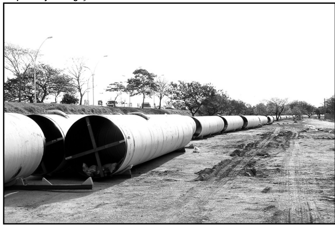
Tubulações do emissário: 13 metros de comprimento e 1,5 de diâmetro
