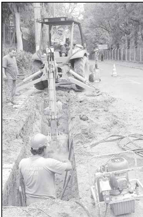
Encanamentos serão ligados à nova rede
