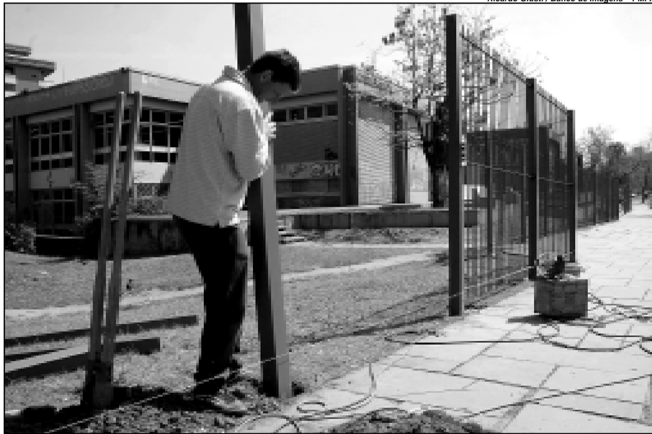
A previsão é de que a obra seja concluída até o final de outubro
