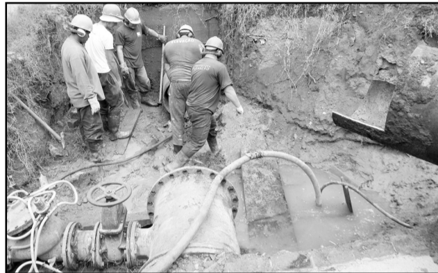
Conjunto de obras vai gerar acréscimo de 27% na produção de água do sistema Tristeza
