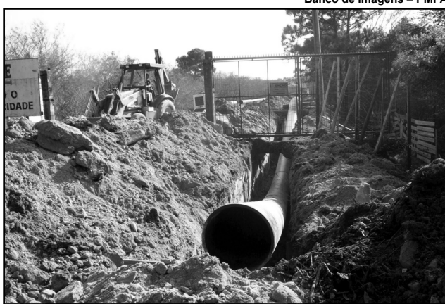
Cerca de 600 metros da tubulação estão assentados
