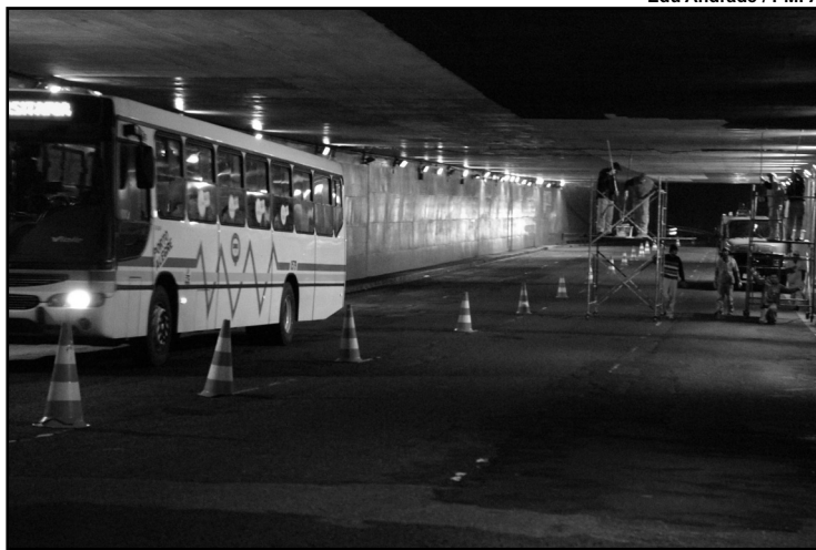
Alterações na circulação viária são necessárias para realização das obras
