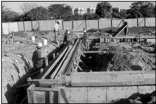
Serão visitadas obras do Projeto Integrado Socioambiental na região
