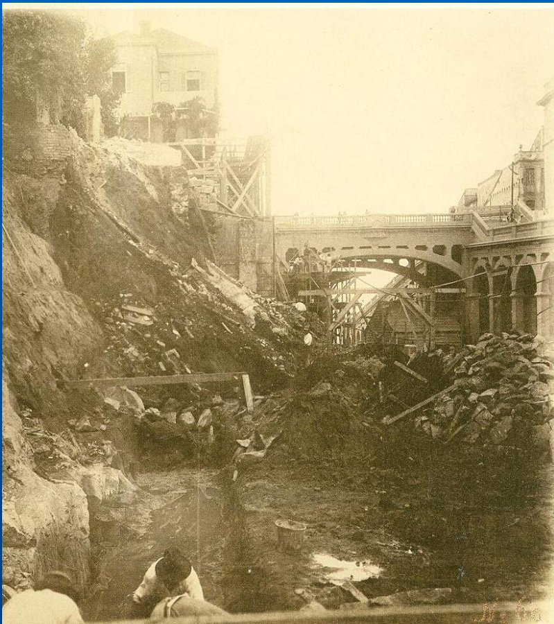
Viaduto Otávio Rocha, 1928-1932
