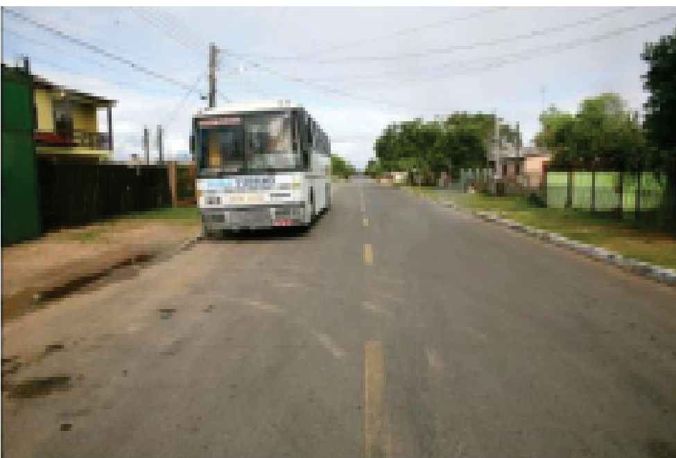
© Canoas, Brasil. Pavimentação de ruas e calçadas são projetos, que entre outros, aumenta a comunicação e mobilidade de comunidades de baixa renda na periferia.
