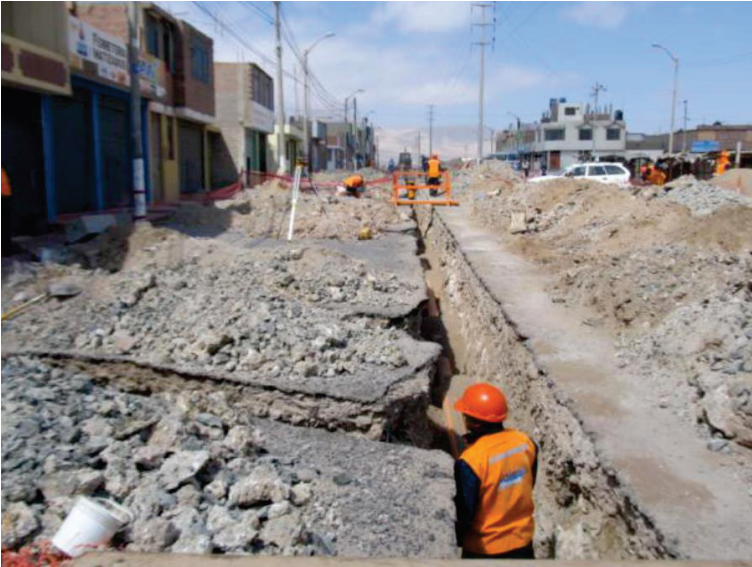
© Município Ilo. Construção de rede de abastecimento águas.
