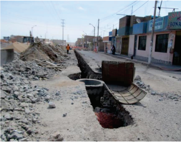
© Município Ilo. Peru. Construção de rede de saneamento de água.
