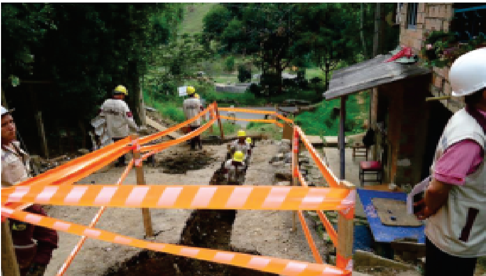
© Município de Medellín. Projeto de drenagem e escoamento de água de chuva financiado através do OP. Comuna 13, Vizinhaça de Eduardo Santos. 2012.
