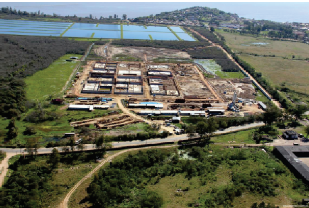
© Porto Alegre. Usina de tratamento de água votado como parte do processo do OP. Essa imagem indica claramente que, quando comparado com outras cidades, a quantidade de soluções diferentes que caem sob "saneamento" quando se considera o OP.
