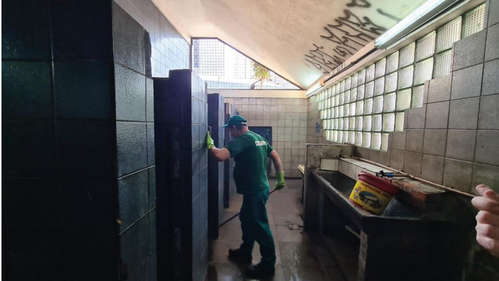
Figura 17 – SANITÁRIO EXISTENTE no Terminal Conceição
