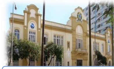
Prédio da Antiga Alfândega
