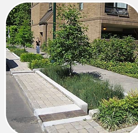
CANTEIROS E PISOS DRENANTES
