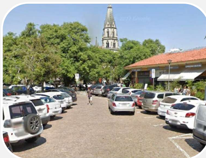
REFORMA E REQUALIFICAÇÃO DA PAVIMENTAÇÃO
