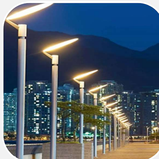
POSTES ALTOS PARA A ILUMINAÇÃO GERAL E PERIMETRAL
