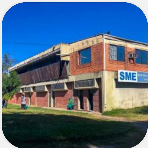
REFORMA DE TODAS AS EDIFICAÇÕES
