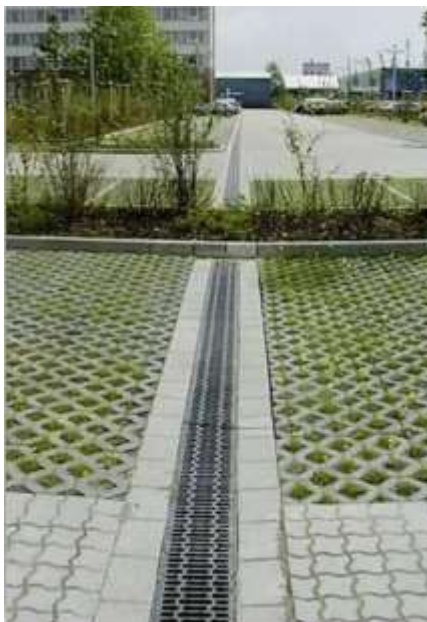
Figura 5.5.2 Imagem de referência para drenagem em pisos
