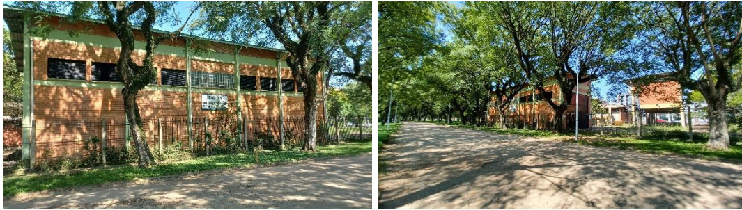
Prédio DMAE – Lado Sul do Parque
