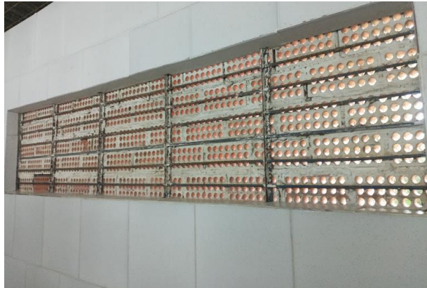
Figura 3.5.3.9.3. Ventilação Banheiros
