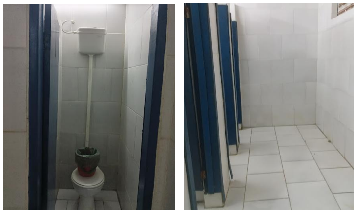
Figura 3.5.3.9.4. Piso, Cerâmica e Equipamentos Sanitários
