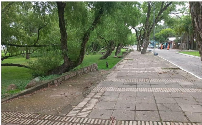
Figura 3.5.3.12.1. Rampa de Acesso na Paralela ao Passeio
