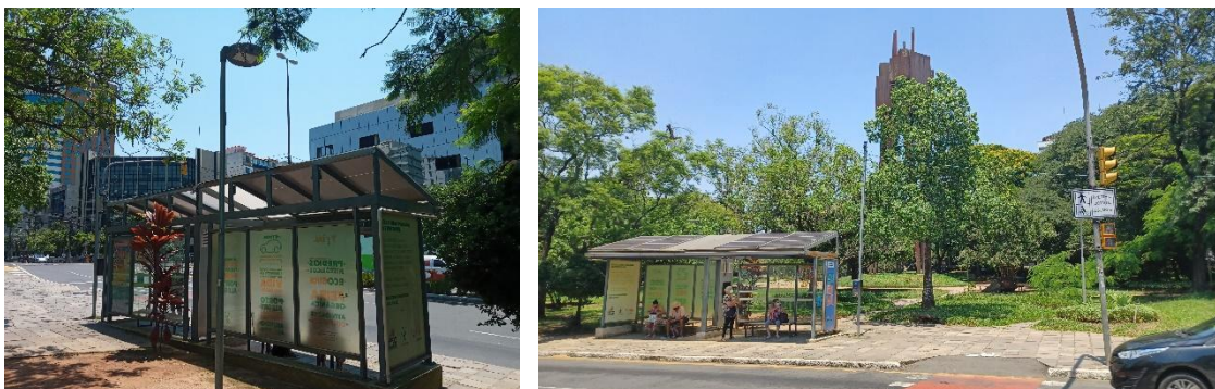
Figura 3.2.2.6.6. Ponto de Ônibus com Captação de Energia Solar
