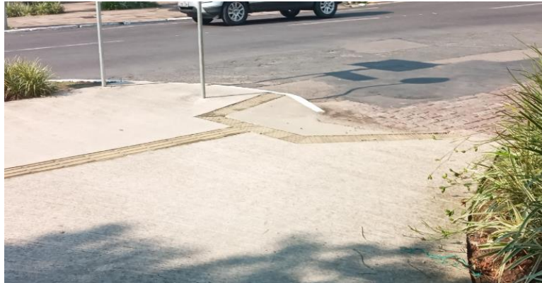
Figura 3.2.2.10.1. Rampa de Acesso
