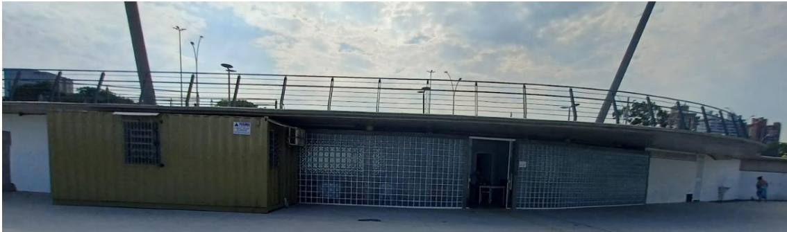
Figura 3.3.2.5.1. Banheiro próximo as Quadras Esportivas
