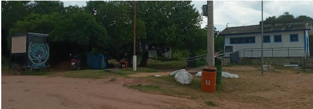
Figura 3.5.3.2.3. Acesso pela Rua Luís Vieira Bernardes
