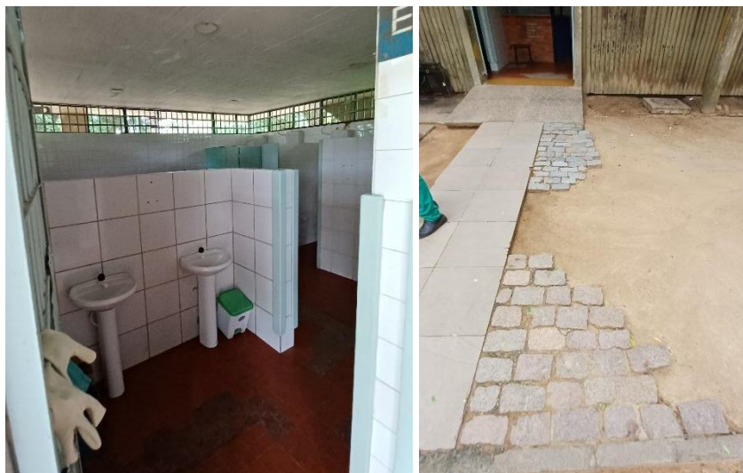
Figura 3.4.2.6.2. Banheiros Área Interna e Acesso a Entrada dos Banheiros
