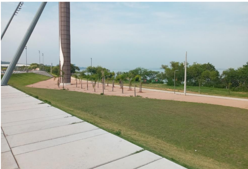
Passeio com Placas de Concreto
