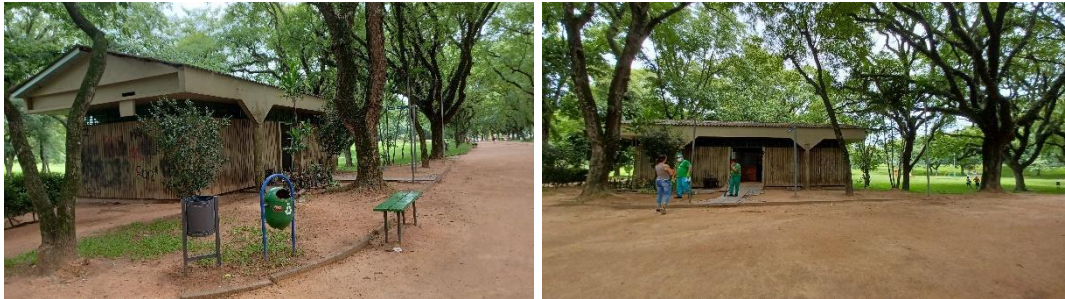
Figura 3.4.2.6.1. Fachadas do Primeiro Banheiro do Lado Norte
