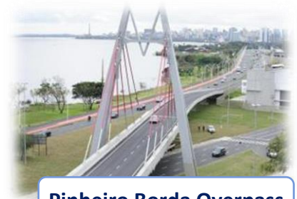
Pinheiro Borda Overpass
