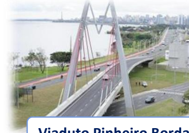
Viaduto Pinheiro Borda
