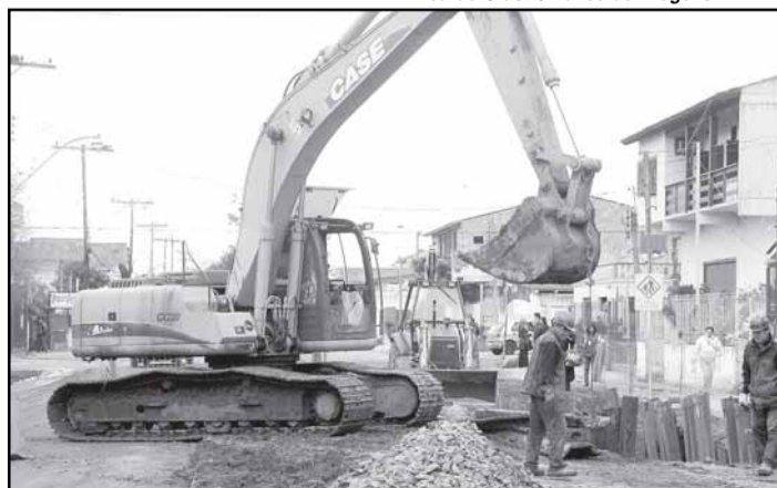
Sistema de Esgotamento Sanitário do Sarandi inclui cinco obras
