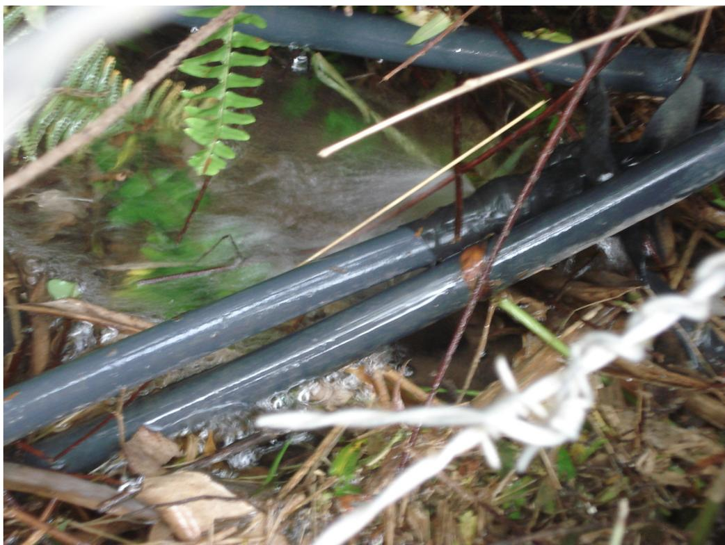
FIGURA 16. Fotos do Loteamento Clara Nunes - Loteamento sem infra-estrutura implantada, com “ligações clandestinas não autorizadas”, caracterizando situação insalubre, vazamentos e perdas para o DMAE. visita realizada pelos autores em 27/05/2008.
