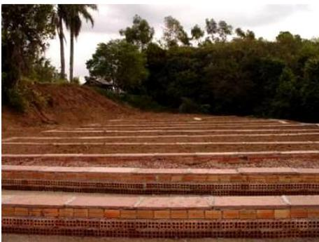
Sistema Solo Planta – Tratamento – Leitos de Evapotransmissão e Infiltração (UFRGS).
