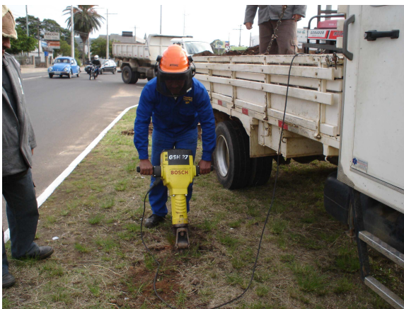
Uso de martelete para rompimento de asfalto e placas de concreto que possam dificultar o uso da perfuratriz (Foto do Biólogo André Duarte Puento).
