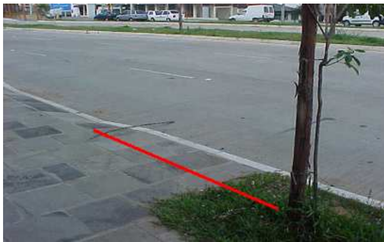
Distância do eixo da muda em relação ao início do rebaixo do meio-fio, considerado complementarmente o alinhamento da entrada de veículos no imóvel (Foto do Biólogo André Duarte Puento).
