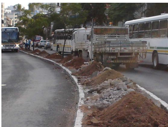
Abertura de covas em canteiro central (Foto do Biólogo André Duarte Puento).
