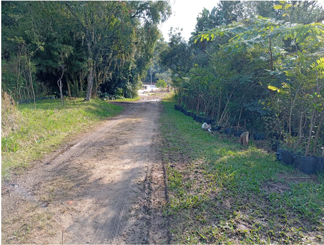
Imagem do Trecho 02 – que receberá o Rachão e a Brita 02 compactados
