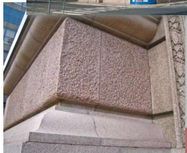
Detalhe dos diversos tipos de acabamento utilizados nos blocos do Granito Ponta Grossa, embasamento do prédio do Memorial do RS.
