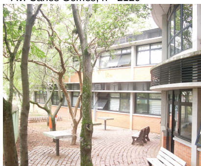
Foto 6 - Prédio atual - 2003 - Av. Carlos Gomes, nº 2120
