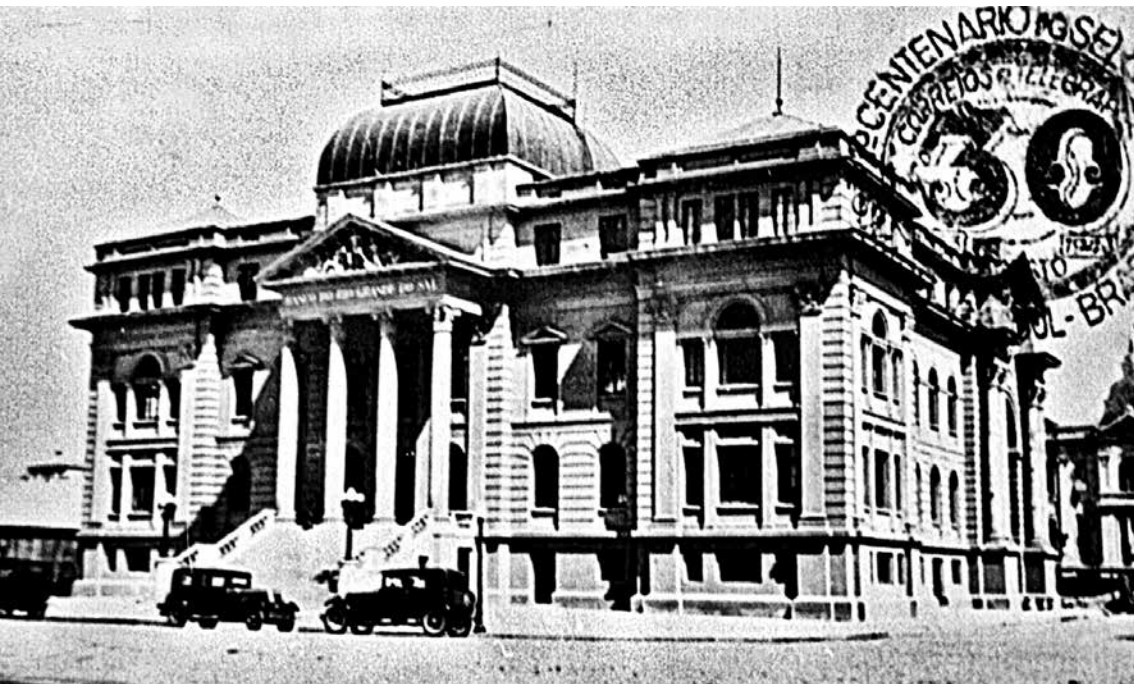
Banco do Estado do Rio Grande do Sul (Av. Mauá, 1155, Porto Alegre). Projeto de Teófilo Borges de Barros (192-). O prédio possuía um frontão escultórico de proporções e cúpulas de chapas de bronze. Possivelmente nos anos 1940, recebeu mais dois pavimentos, alterando sensivelmente as características do edifício, localizado em privilegiado sítio, junto aos atuais Memorial do Rio Grande do Sul, MARGS e Inspeção da Receita Federal (antiga Alfândega).
