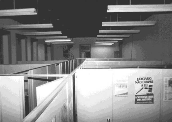
Divisórias tipo naval obstruindo paredes e a visão dos ambientes
