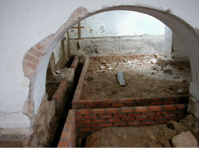
Execução de vala de drenagem para coleta de água e ventilação das fundações
