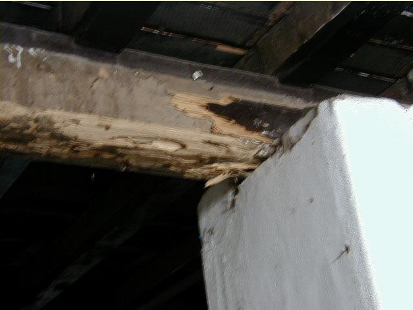
Ataque generalizado de insetos xilófagos -cupins
