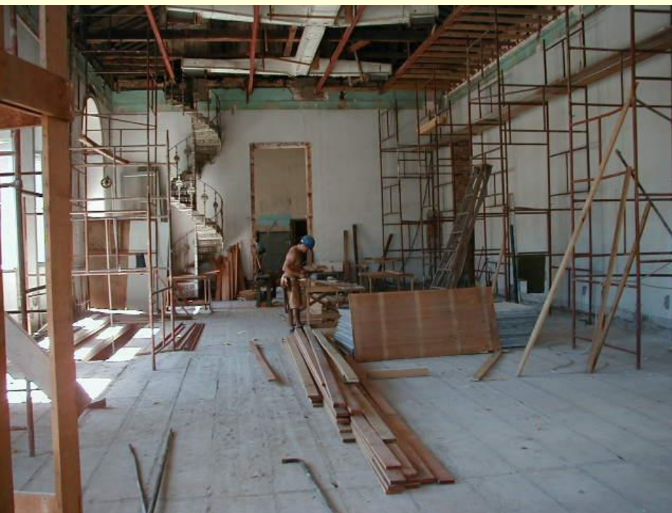
Rebaixamento da laje Roth na área das assessorias do GP
