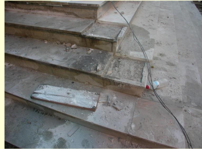
Colocação de placas de mármore nas lacunas
