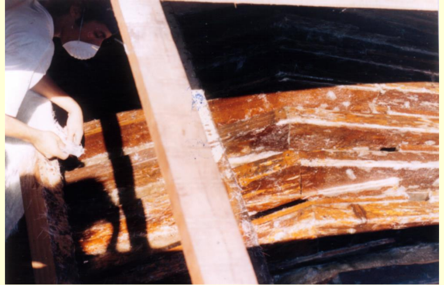
Substituição de taliscas, imunização, aplicação de fibra de vidro e resina
