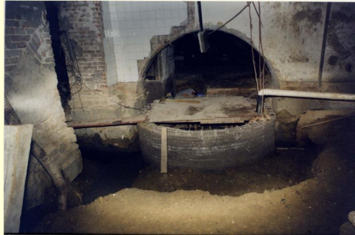
Execução de vala de drenagem para coleta de água e ventilação das fundações
