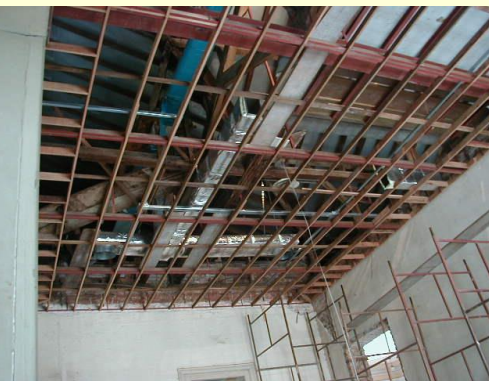
Execução das instalações de ar condicionado e estrutura do forro
