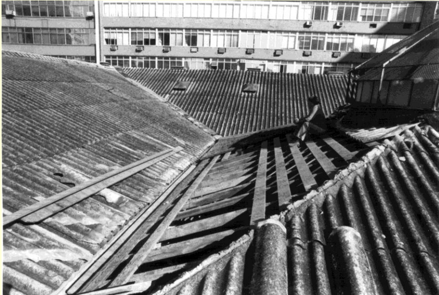
Remoção das telhas de fibrocimento
