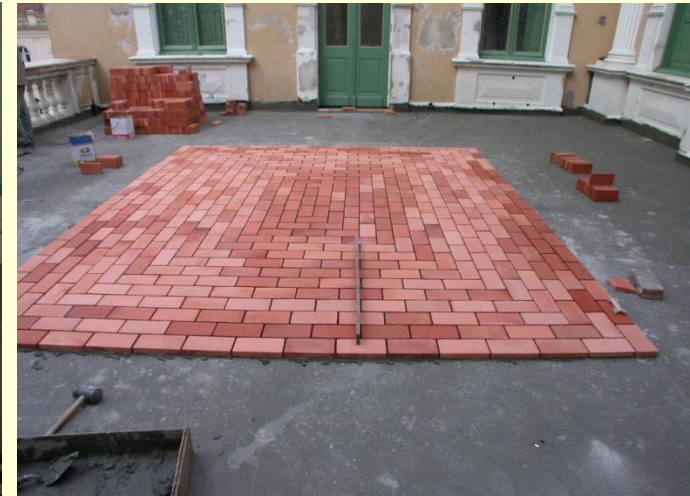
Montagem da paginação do piso do terraço
