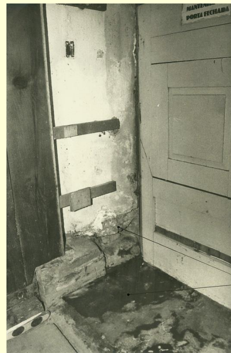
Depósito de materiais, fiação exposta, umidade excessiva
