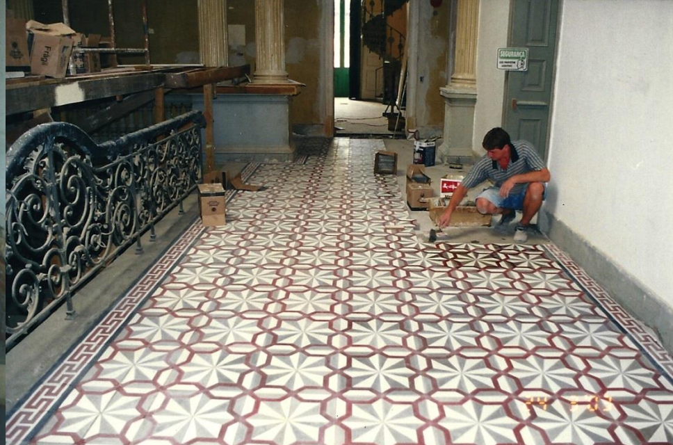
Colocação de piso de ladrilho hidráulico sobre barroteamento e painel Wall
