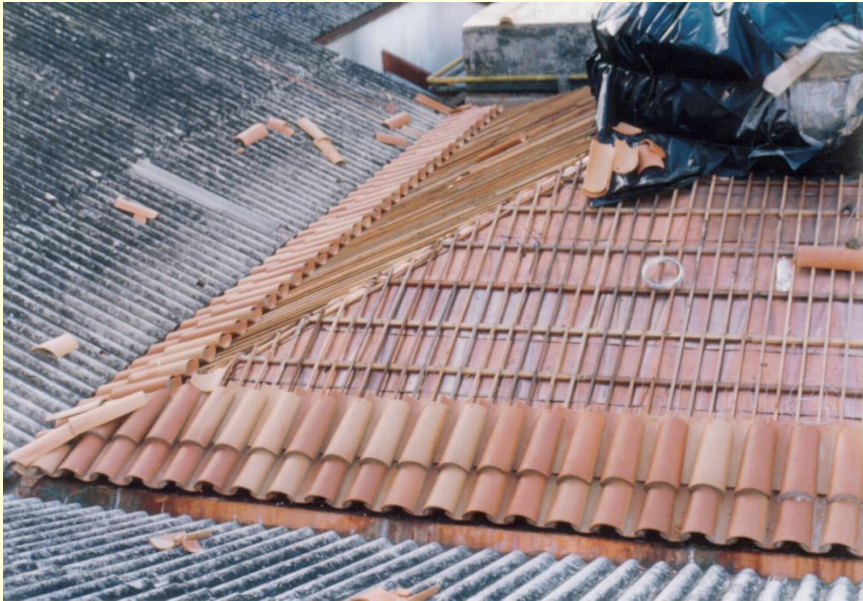
Colocação de sub-telhado em chapa de cobre e telhas de barro capa-canal conforme o telhado original
