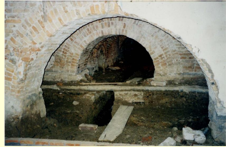
Rebaixamento do piso e execução de valas
