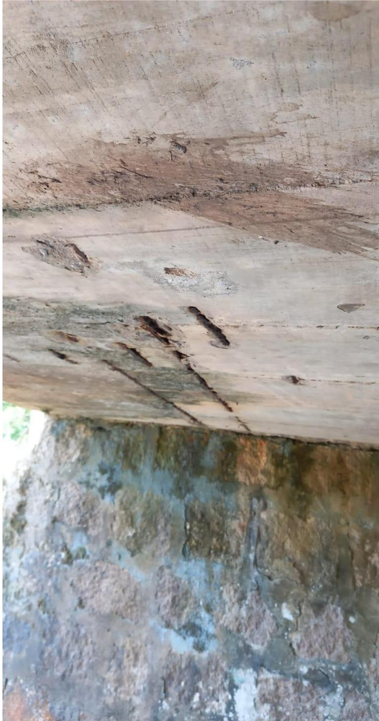
Foto 4 – Armaduras expostas com oxidação
