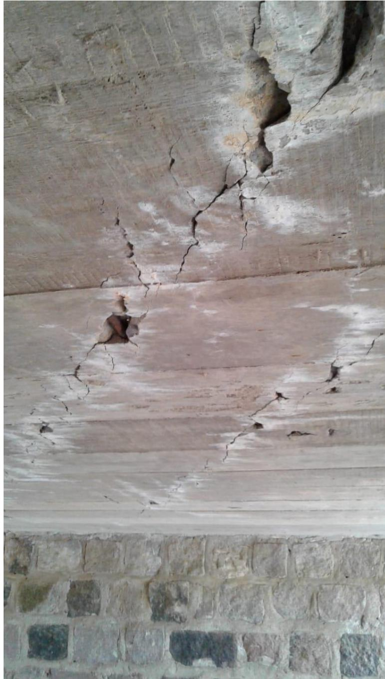
Foto 3 – Rachaduras acentuadas na laje de concreto armado
