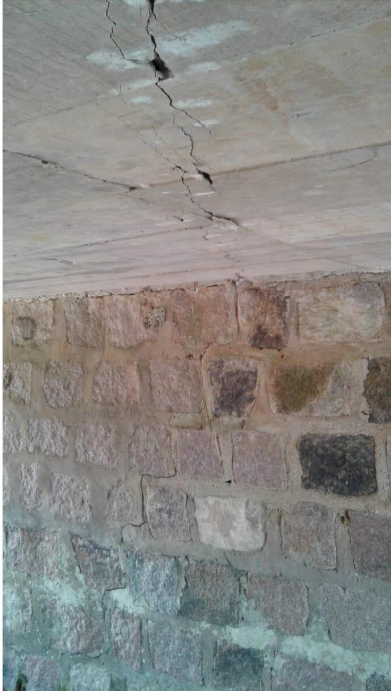
Foto 2 –Rachadura na laje de concreto armado e na alvenaria de bloco de pedra
