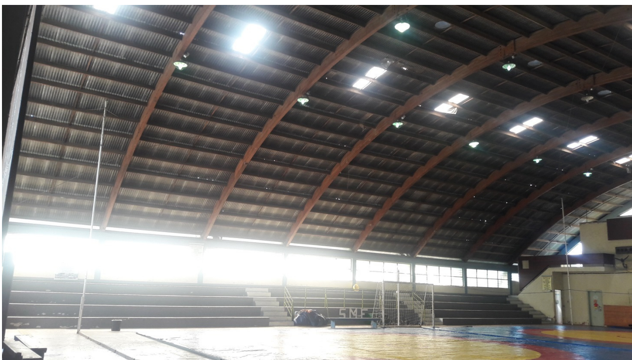
Foto 10 – Vista geral do interior do Ginásio Lupi Martins, destacando a estrutura de cobertura e arquibancadas.
