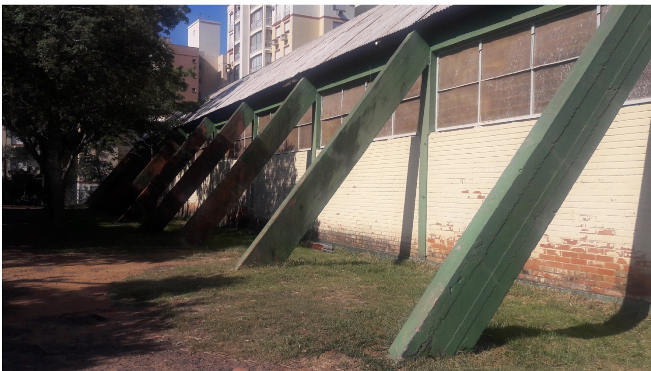
Foto 9 – Detalhe dos pilares inclinados de concreto armado que apoiam os arcos.
