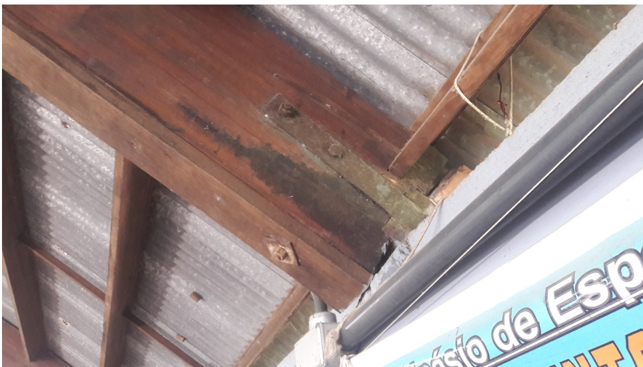
Foto 3 – Detalhe da extremidade do arco de madeira rotacionado em relação ao seu apoio e com sinais de umidade.
