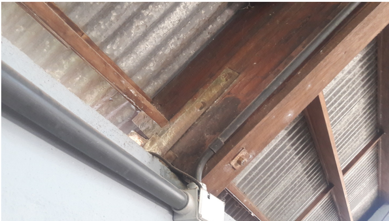
Foto 3 – Detalhe da extremidade do arco de madeira rotacionado em relação ao seu apoio e com sinais de umidade.
