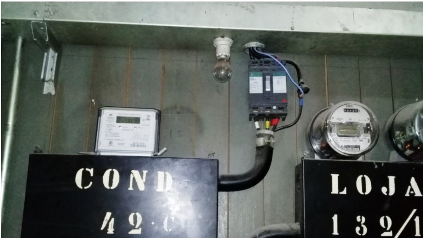
Figura 8 – Derivação de condutor desconhecido (azul) desde o neutro da medição do condomínio
