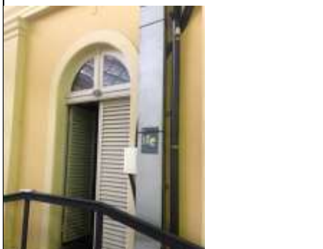
Foto 1- Local de acesso
