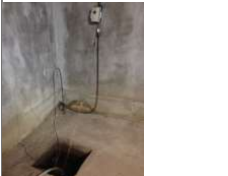
Foto 3 – Poço e Bomba Submersa
