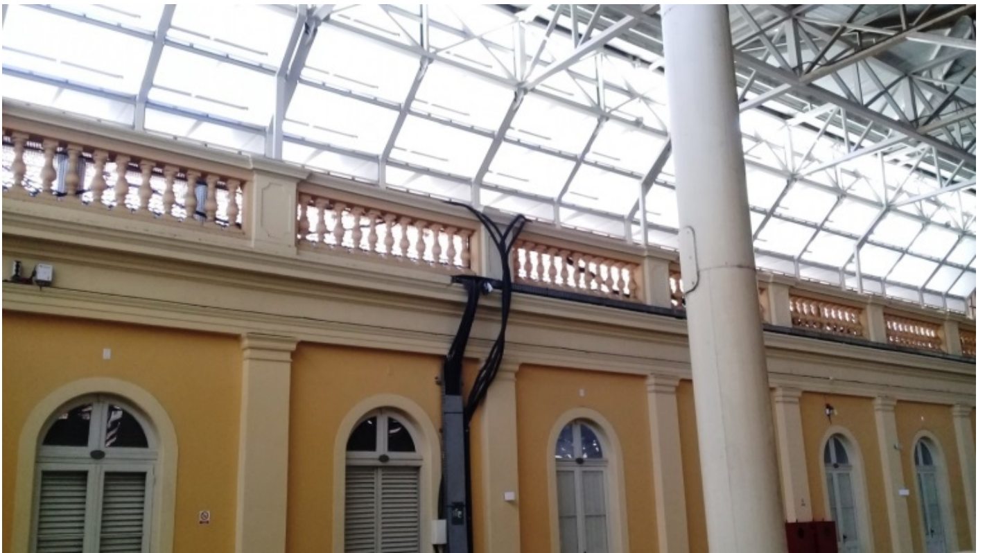
Figura 1 - Condutores expostos diretamente à alvenaria
