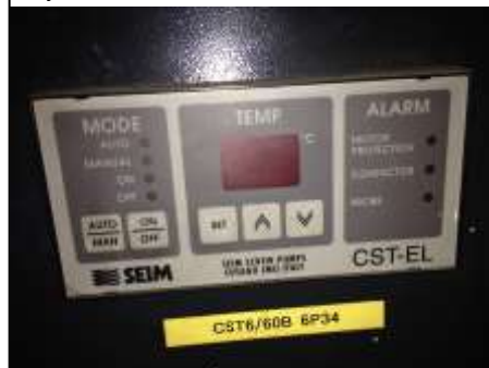
Foto 10 - Casas de Máquinas 1 e 2 / Máquinas 2 - Conjunto Motor Oleodinâmico - Painel
