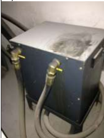
Foto 9 - Casas de Máquinas 1 e 2 / Máquinas 2 - Conjunto Motor Oleodinâmico
