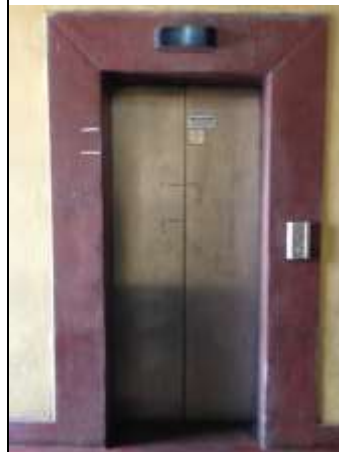
Foto 2 – Porta do Elevador – Quadrante III – 2º Pav.
