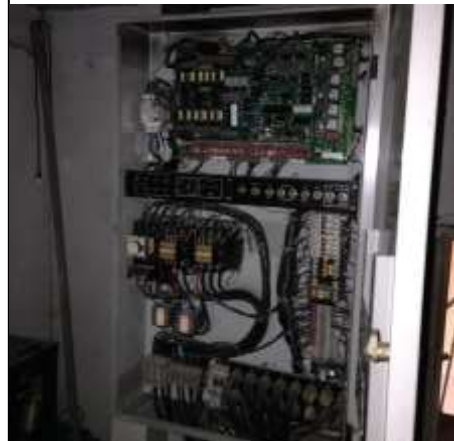
Foto 12 - Casas de Máquinas/ Painéis de Comando e Automação – vista interna
