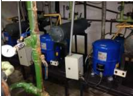
Foto 1- Compressores, Condensadores e Tubulações
