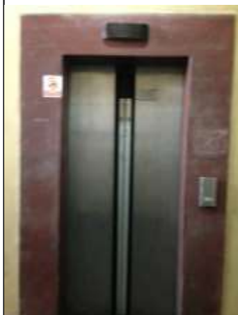
Foto 1 – Porta do Elevador – Quadrante III - Térreo
