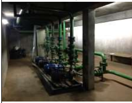
Foto 2 – 4 bombas de recalque
