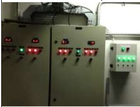
Foto 3 – Painéis de Comando e Proteção
