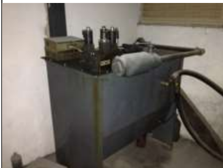
Foto 9 - Casas de Máquinas 1 e 2 / Máquinas 2 - Conjunto Motor Oleodinâmico
