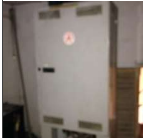
Foto 11 - Casas de Máquinas /Painéis de Comando e Automação – vista externa
