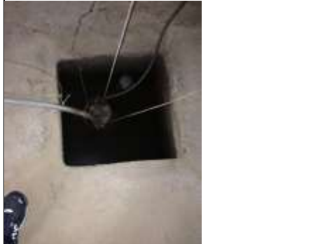
Foto 4 – Poço e Bomba Submersa
