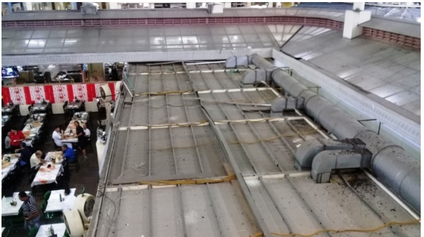
Figura 2 - Condutores expostos por sobre cobertura dos restaurantes provisórios
